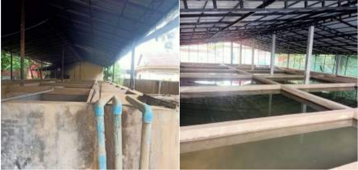
រូបភាពទី១២៖ អាងប្រព្រឹត្តកម្មចាស់(ខាងឆ្វេង) ត្រូវបានជំនួសទាំងស្រុងដោយអាងប្រព្រឹត្តកម្មថ្មី(ខាងស្តាំ)
